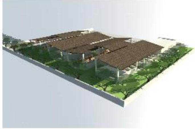
पेठ क्र. 2, इंद्रायणीनगर, भोसरी येथे भाजी मंडई बांधणे. Construction of Bhaji Mandai in S.No. 2 Indrayani Nagar, Bhaosari.
